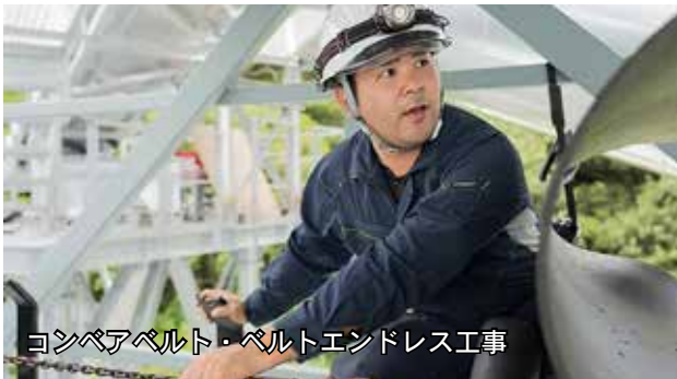
変・減速機の分解整備
