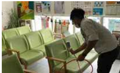
病院の待合スペースのコーティング作業
