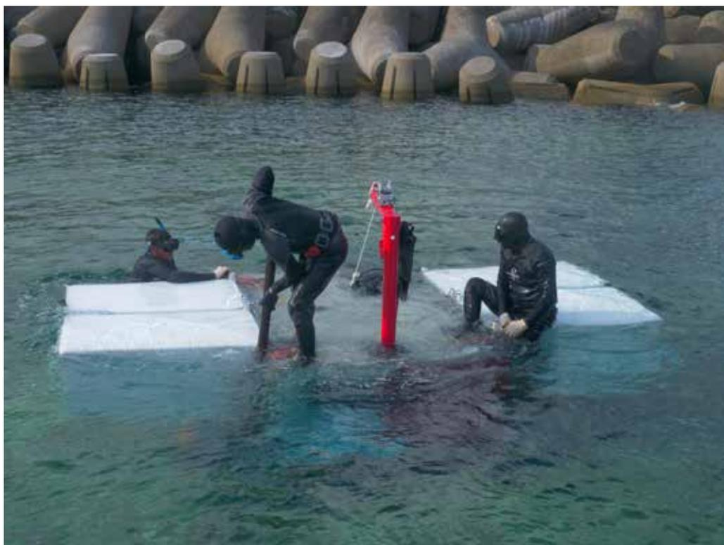
ボートで運んだ波力発電機をサンゴ石灰岩に固定する。提供: OIST
