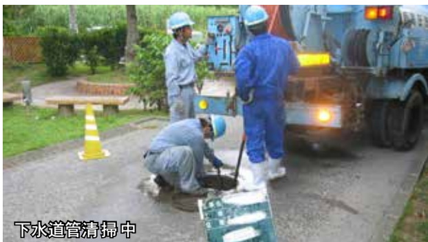
下水道管の更生工事中
