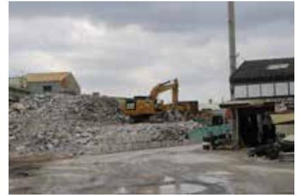
コンクリート殻は再生破碎石や再生砂として製品化される
