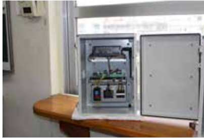
ソーラー電源駆動型検針テレメーター
