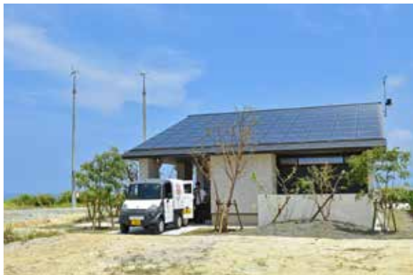
サステナブルリビング実験棟
