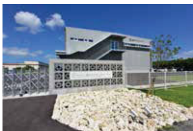
うるま市勝連南風原の本社・工場
