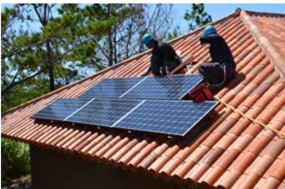
屋根に設置されたソーラーパネルは、各家庭のエアコンに電力を供給します。
