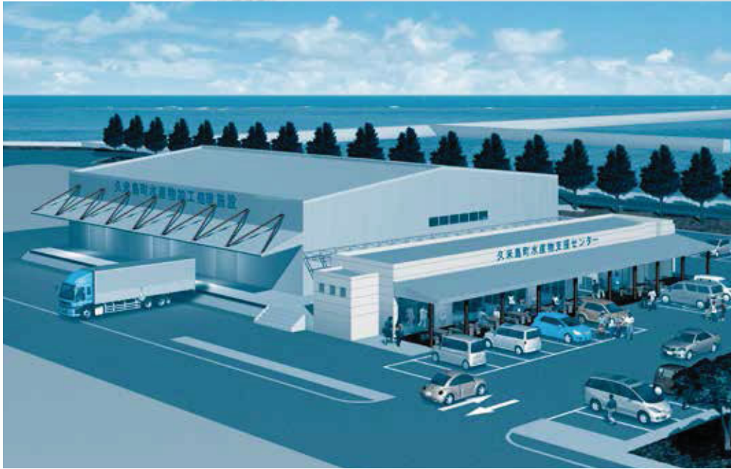
水産物加工処理施設・海業支援施設進捗状況(平成27年3月撮影) 施設全景
