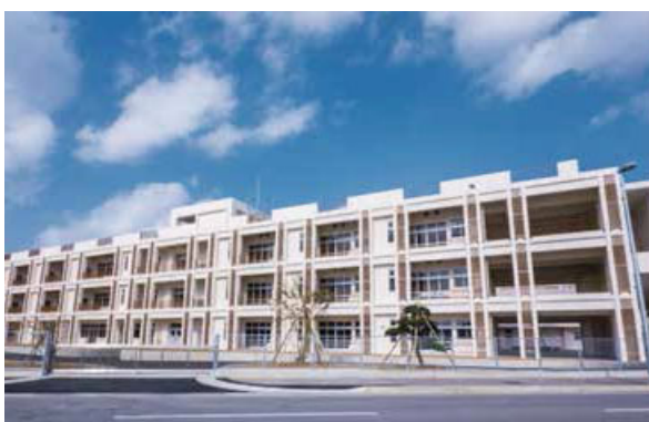
与那原東小学校校舎改築工事
