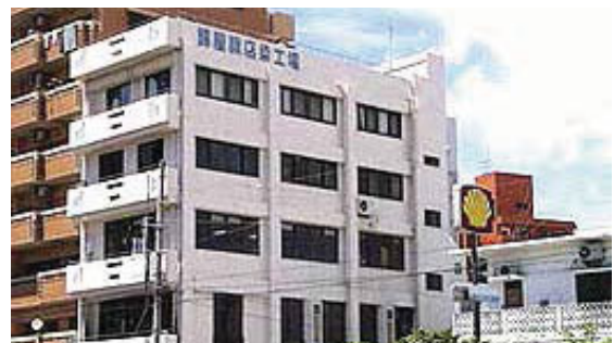
事務所と工場のある那覇市泊の本社ビル
