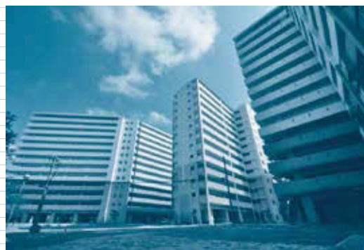
宇栄原市営住宅完成棟
