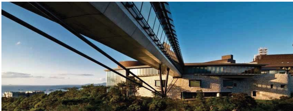
OISTセンター棟と第2研究棟を結ぶスカイウォーク(空中回廊)
