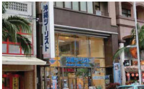
那覇市松尾の本社ビル
