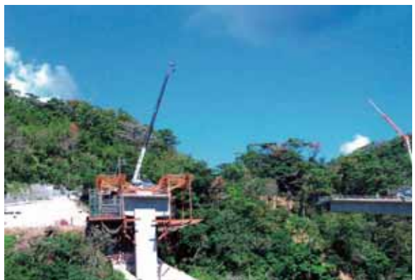
土木工事(橋梁現場作業)
