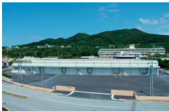
4千トン級冷蔵倉庫(本部港)
