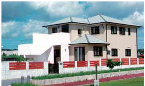
スチールハウス施工例
