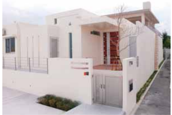
コンクリート住宅施工例
