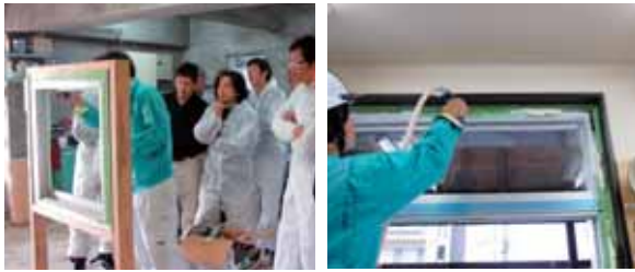
左：講習風景 右：枠の隙間に吹付、発泡、接着固定する。
