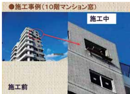
高層階での施工も特別な足場不要
