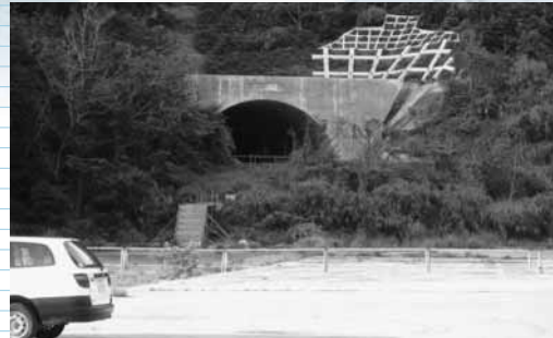
③2号トンネル世富慶付近 平成23年6月撮影
