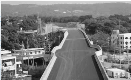
②1号トンネル付近(起点側撮影) 平成23年6月撮影
