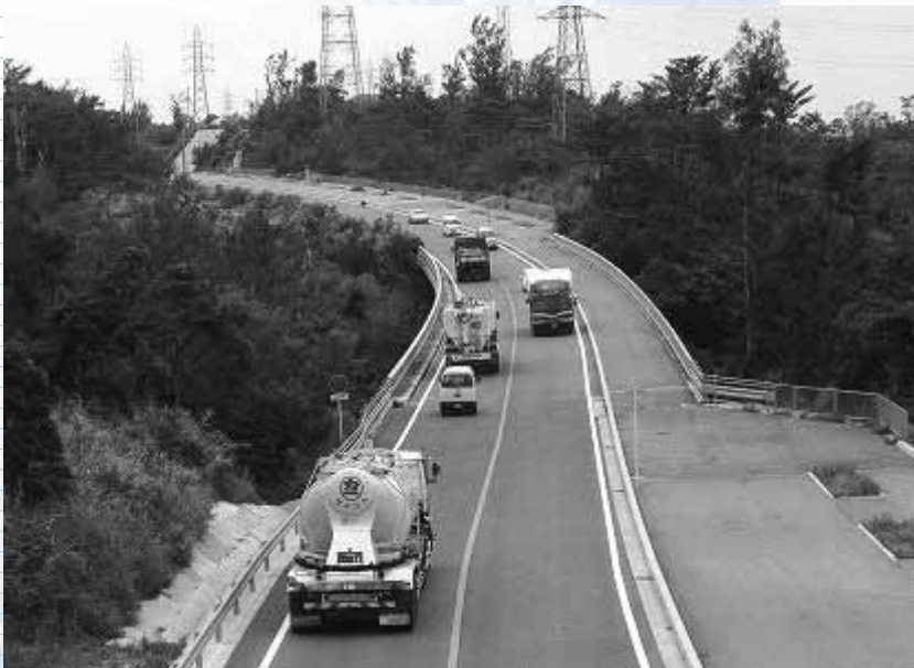
2号跨道橋より 終点を望む
