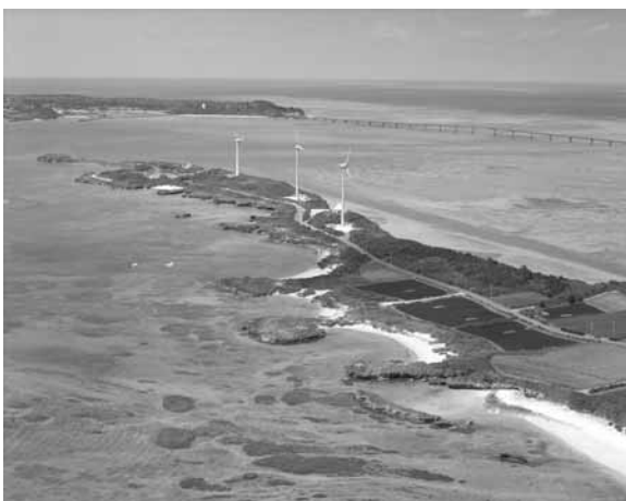
狩俣風力発電設備
