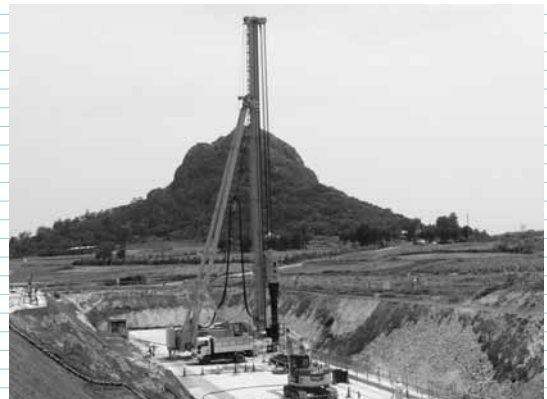
地下ダム施工状況
