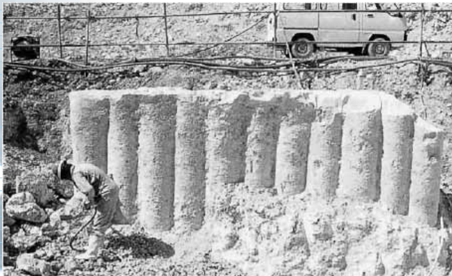
止水壁モデル(攪拌型地中連続壁工法)
