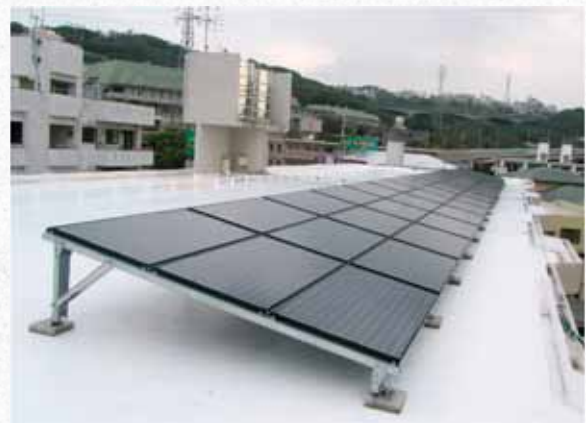
共同住宅の設置事例
