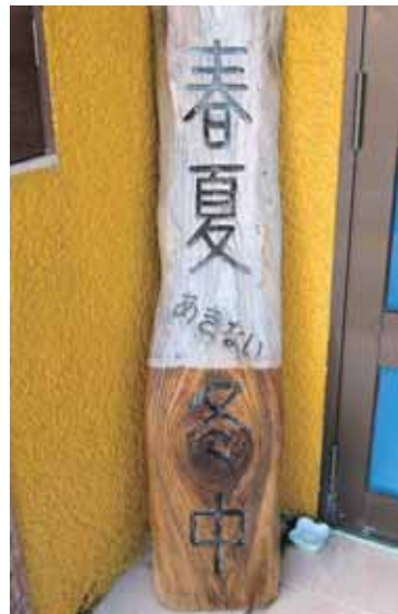
上半部分が施工前、下半部分が施工後で、樹の木目等質感を出し、樹の香りまで再生
