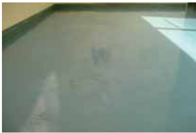
塩ビタイル施工前
