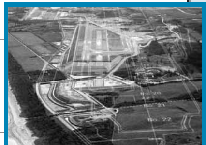
事業進捗状況(08年11月撮影、画像は沖縄県土木建築部新石垣空港パンフレットより)
