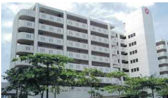
機械工事を施工した県営古波蔵第3団地
