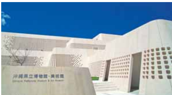
空調設備を施工した沖縄県立博物館・美術館
