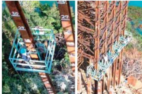
SBSゴンドラ工法による構台と桟橋架設の様子(ワルミ大橋)
