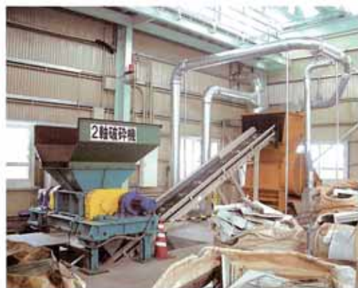
廃家電やOA機器の基板やプラスチックはこの二軸一軸破砕機で細かく砕きます。
