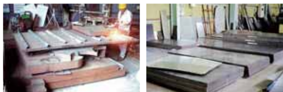
鋼材加工ヤード(上)、加工現場及び鋼材倉庫等の様子
