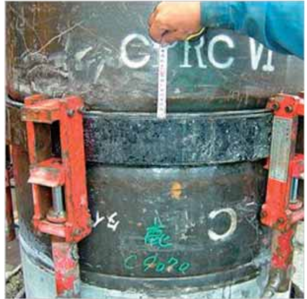
無溶接継ぎ手「ペアリングジョイント」
