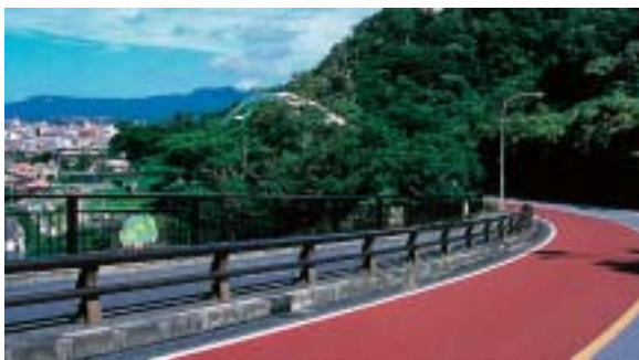
樹脂系滑り止め舗装
