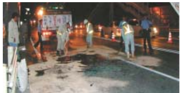
油漏れ除去作業
