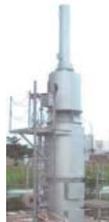
廃棄物焼却炉
