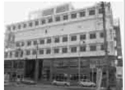
名護市産業支援センタービル (平成19年9月供用開始予定)
