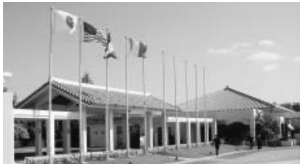
名護市内万国津梁館
